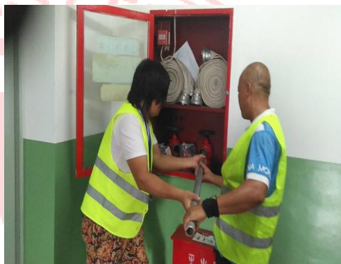
▲ 更换消防栓栓头
