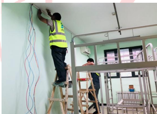
△电路改造现场
