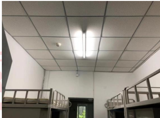
△修缮完成宿舍
