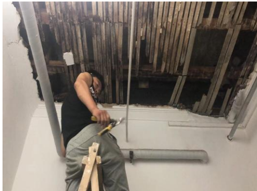
△吊顶修缮现场
